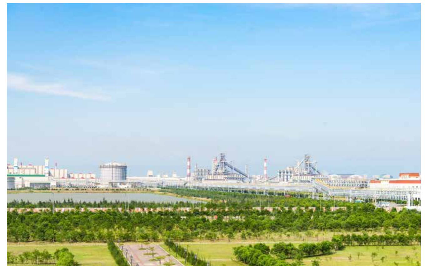
台塑河靜鋼鐵公司
